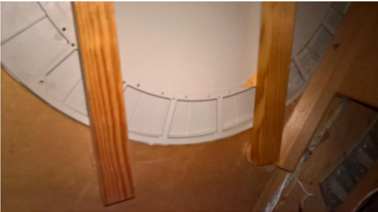
Vue sous les voies de garage de la rotonde couverte : découpage du plateau et pose de tasseaux
